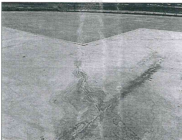
Grieta en forma de X, color claro corresponde a zona de recubrimiento.
