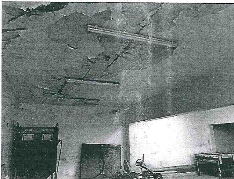
Grietas losa superior (3), zona C.
