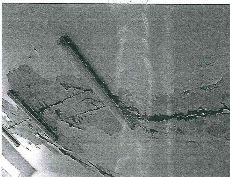
Grietas losa superior (4), zona C.
