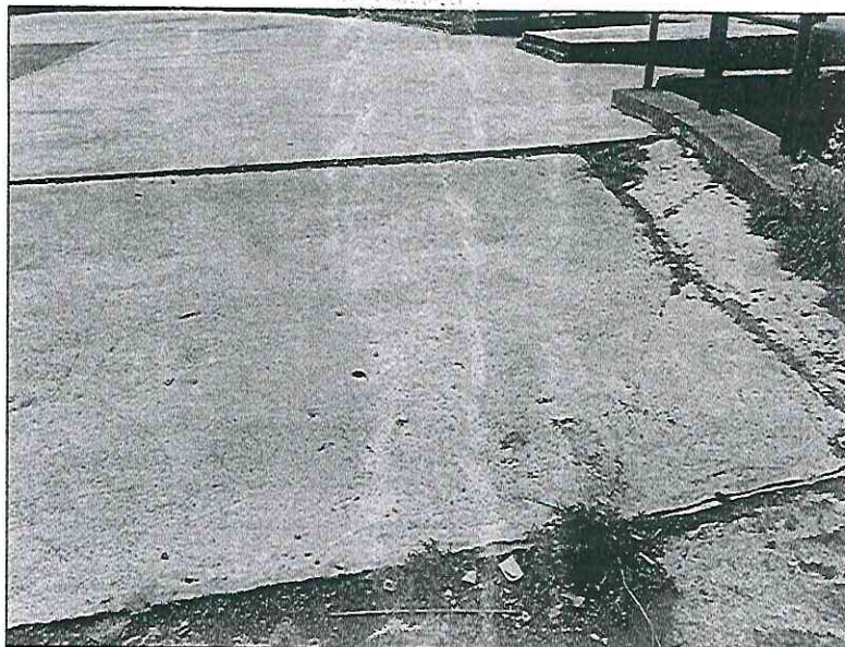
Asentamiento de losa, zona escalera.
